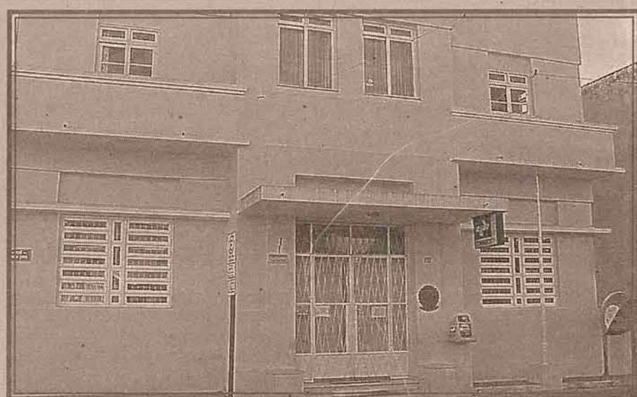
Agência dos Correios, à rua Oswaldo Cabral em nossa cidade. Arquitetura modernista, porém de característica oficial, representativa de obras públicas, na década de 40.
